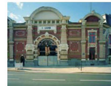
La Condition Publique réhabilitée en équipement culturel, place Ficherbe.
